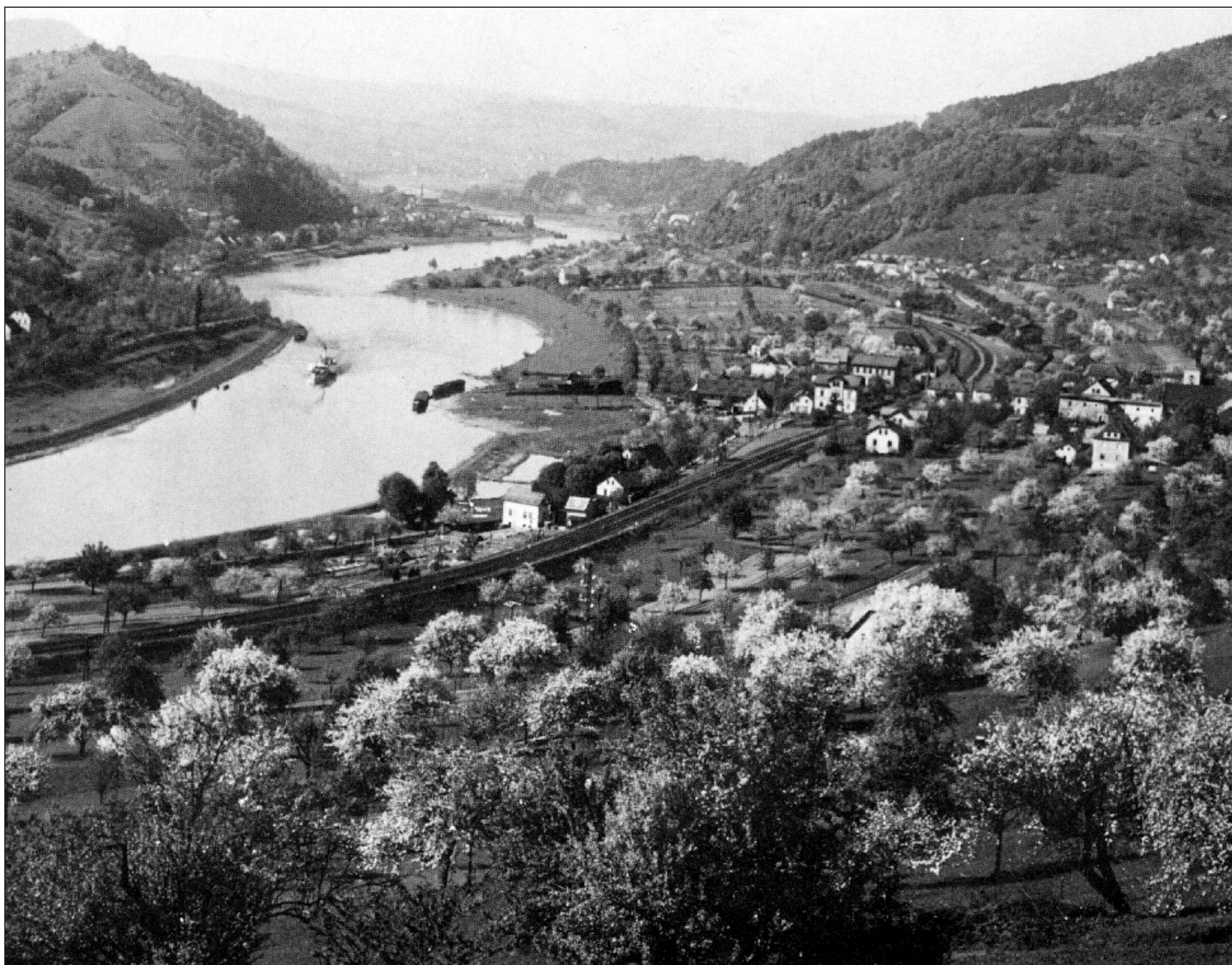
Blick auf Tichlowitz während der Baumblüte. Tichlowitz ist am rechten Ufer der Elbe gelegen.
