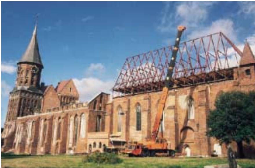
Der Chorraum erhält eine neue Dachkonstruktion, Aufnahme: Deutsches Zentrum für Handwerk und Denkmalpflege, Propstei Johannesberg, Fulda e. V.
